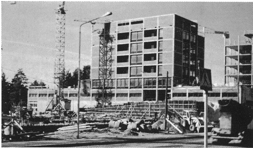
Kuurojen Liiton uusi toimistohuoneisto Espoossa tulee sijaitsemaan tässä rakennuksessa vasemmassa siivessä toisessa kerroksessa. Muuttamaan liitto pääsee tammikuussa. Uusi osoite on: Maapallonkuja 1, 02210 Espoo 21.
