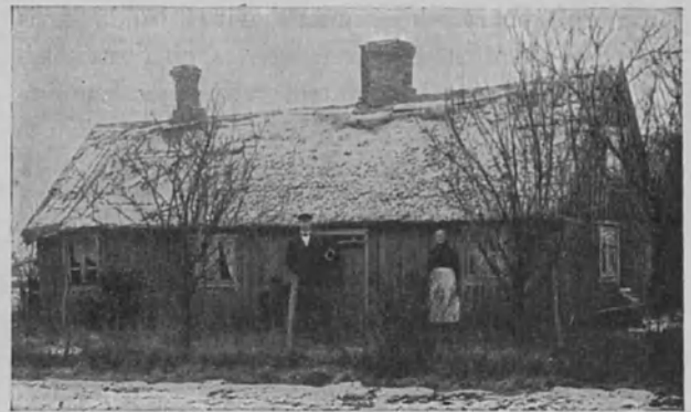
Kuuron miehen ja hänen äitinsä yhteinen koti, vanha rakennus Halmstadin kaupungin lähellä.
